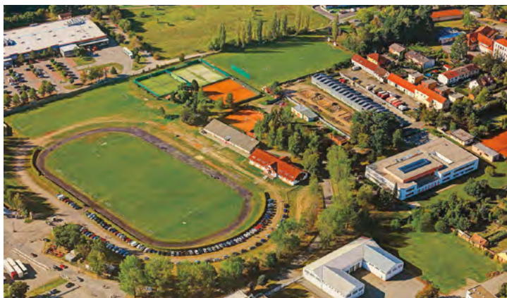
Sportovní areál a Tělovýchovné a sportovní centrum Jihočeské univerzity v ulici Na Sádkách
