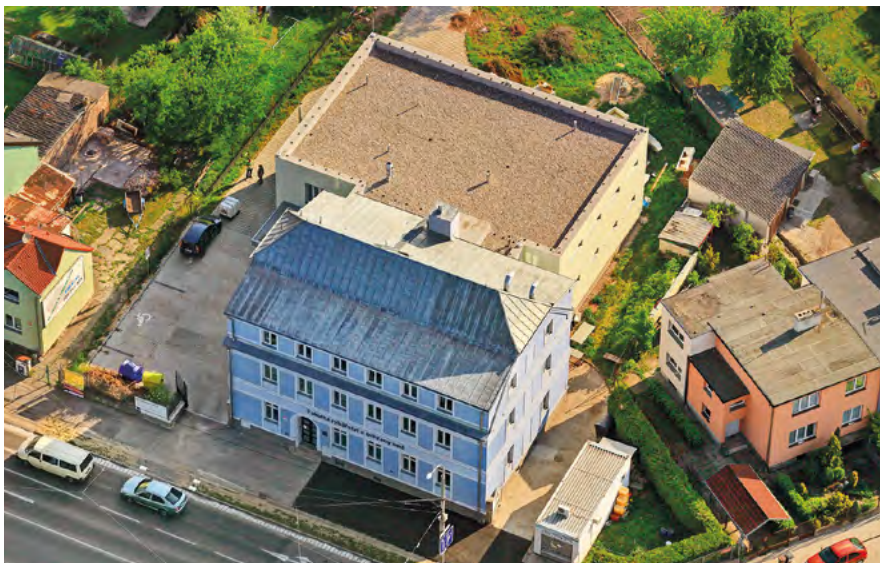
Budova Fakulty rybářství a ochrany vod Jihočeské univerzity v Husově ulici
